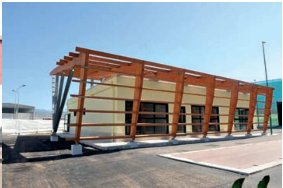
L'impianto di compostaggio di Salerno
